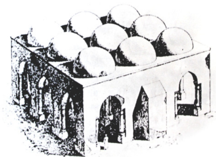
۱۴ - تصویری از ساختمان حرم و مسجد قبل از آب گرفتگی شان
