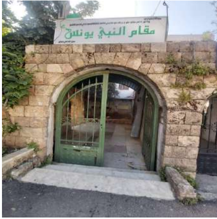
صورة لمداخل ومسجد المقام
