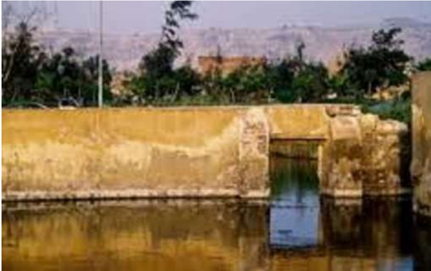
12 - صورة باب مدخل المسجد والمقام وتبدو المياه فيه.
